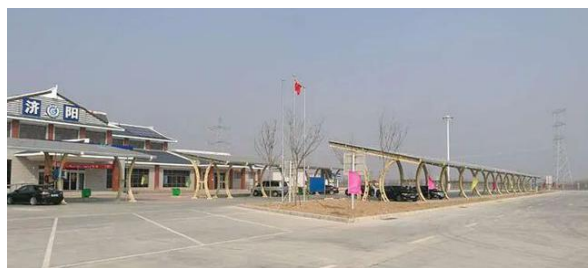
浙江衢州华东村建光伏停车场，年增收 15 万元
